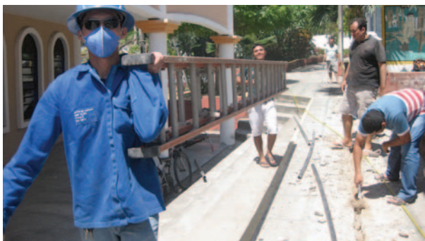
Dia 07 (sexta-feira): Mutirão das Instalações Elétricas
